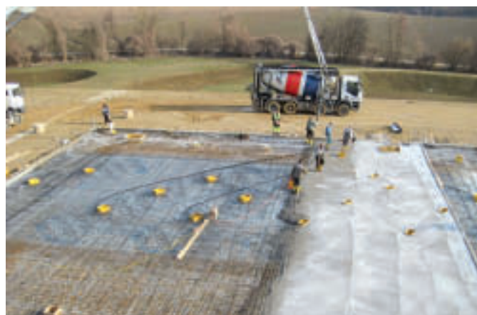
Bild 2. Betonage der Bodenplatte
