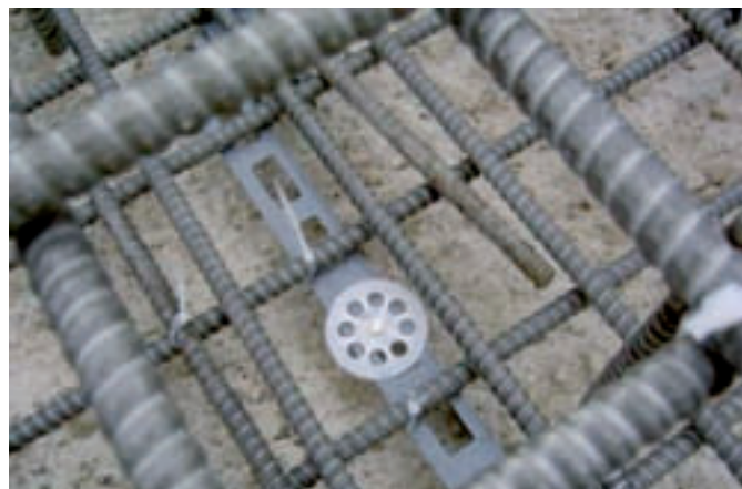
Bild 3. Absicherung der GFK-Bewehrung gegen den Auftrieb (Fotos: FiReP® International)
